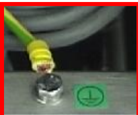
死金属接地 及贴上接地 标签
